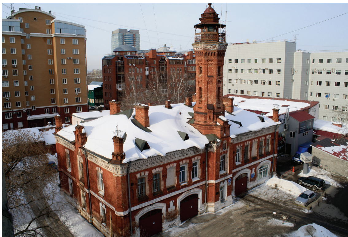
Рис. 10. Пожарная каланча. Современное состояние
